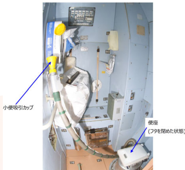
「ズヴェズダ」後方に 設置されているロシアのトイレ Image by NASA
