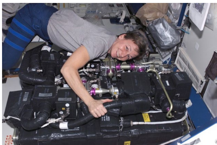
図 5.2-4 米国の二酸化炭素除去装置(CDRA) (修理時の写真) (©NASA)
