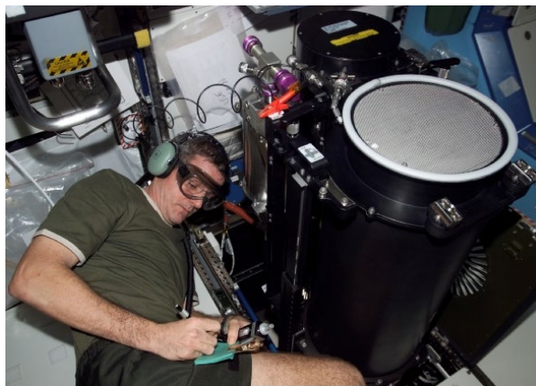
図 5.2-6 米国の有害ガス除去装置(TCCS) (修理時の写真) (©NASA)
