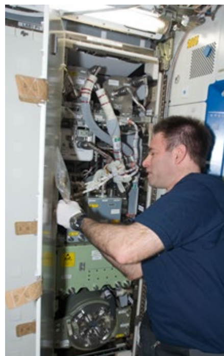
図 5.2-2 米国の酸素生成装置 (OGS) (©NASA)
