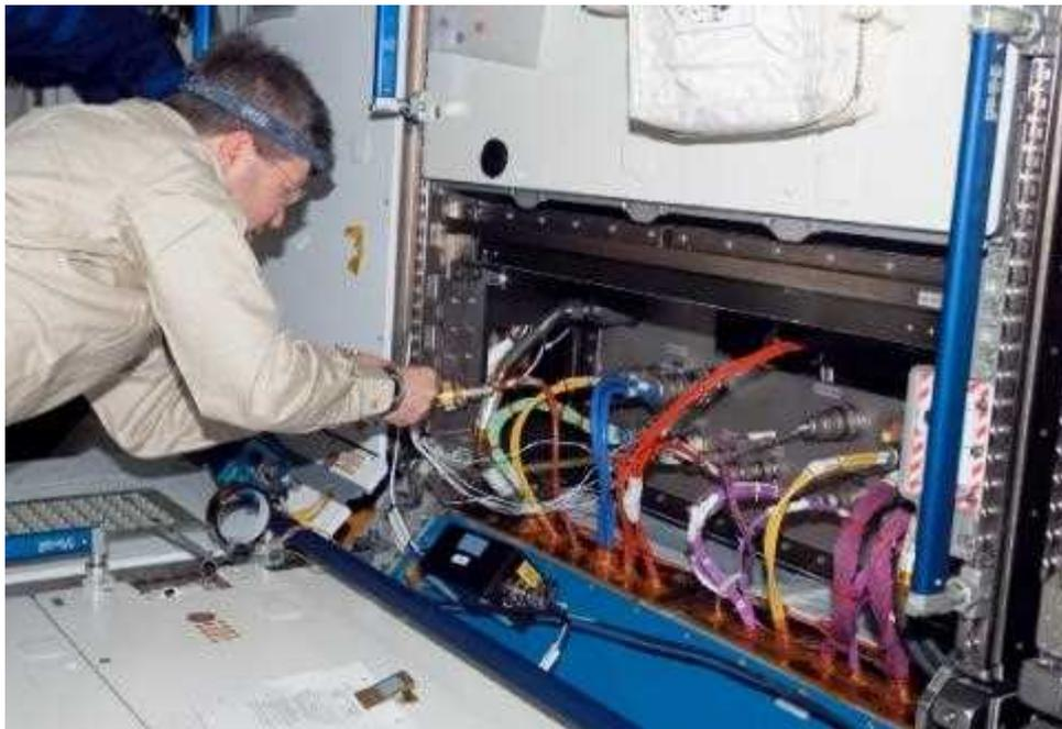
図 4.4-4 ハーモニーの電力・通信配線のトラブルシューティング（故障箇所の究明）（©NASA）
